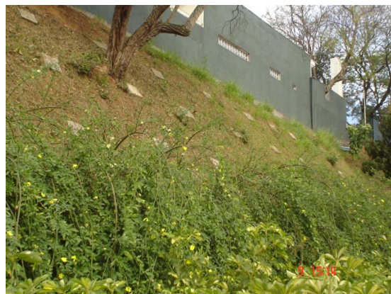
Vista geral do talude após estabilização
