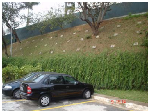
Talude após o término da obra
